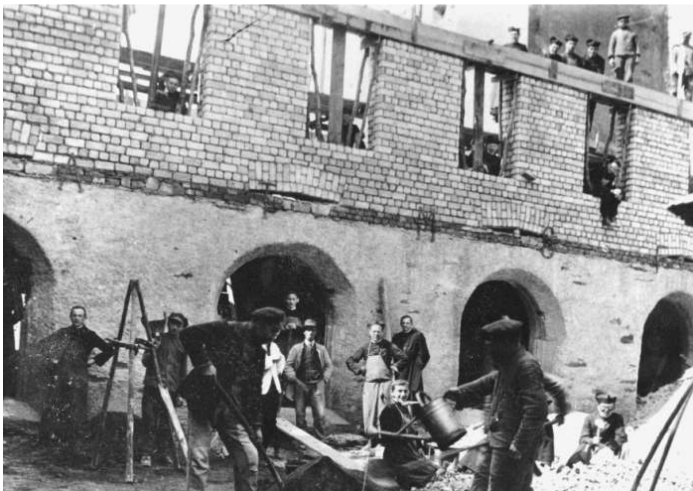
Die Missionare packten selbst mit an. Die Aufnahme eines unbekanntem Photographen zeigt die Arbeiten am Westflügel des Quadrums. Die untere Mauer mit den Arkaden könnte noch vom romanischen Kreuzgang stammen. Foto: MSF, Bildbearbeitung www.kunstimlicht.de
